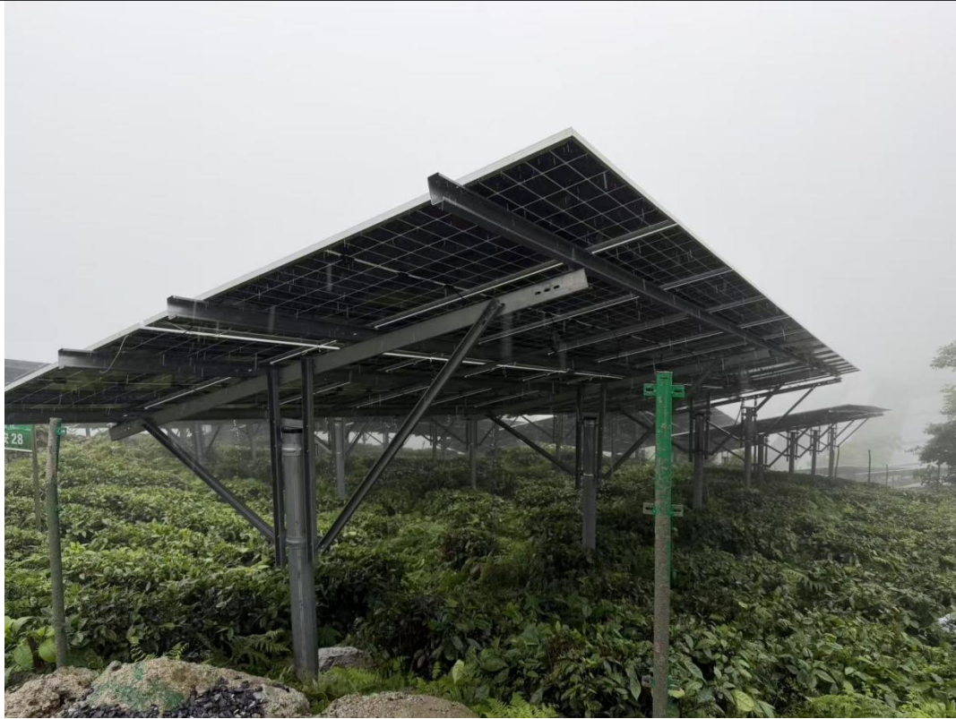
已建成板区现状照片
