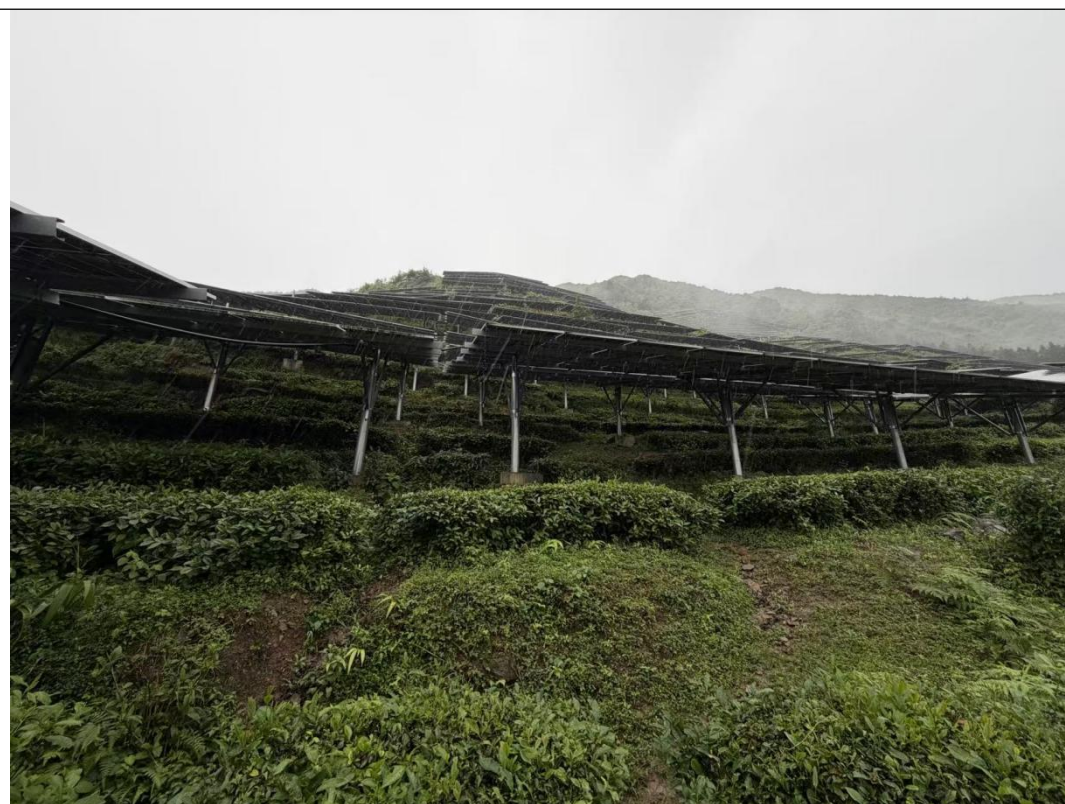
已建成板区现状照片
