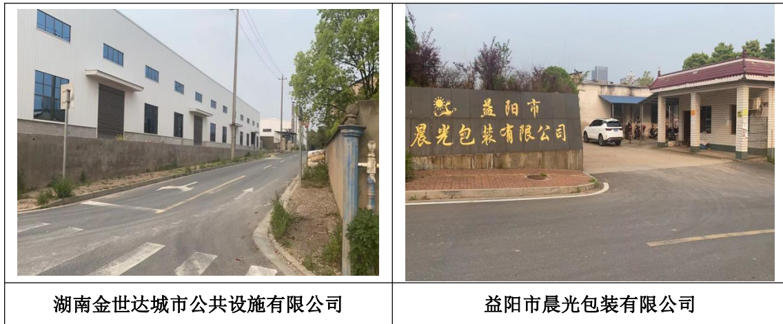
图 4.2-1 现场踏勘照片
