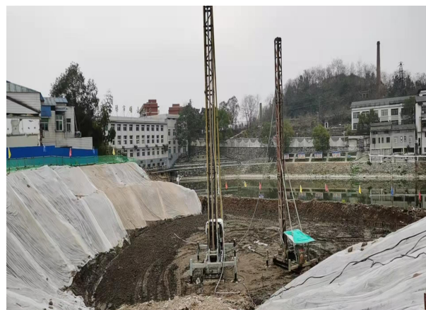
施工防尘网覆盖
