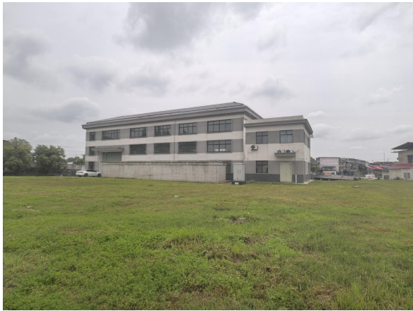
泵房及压力水箱
