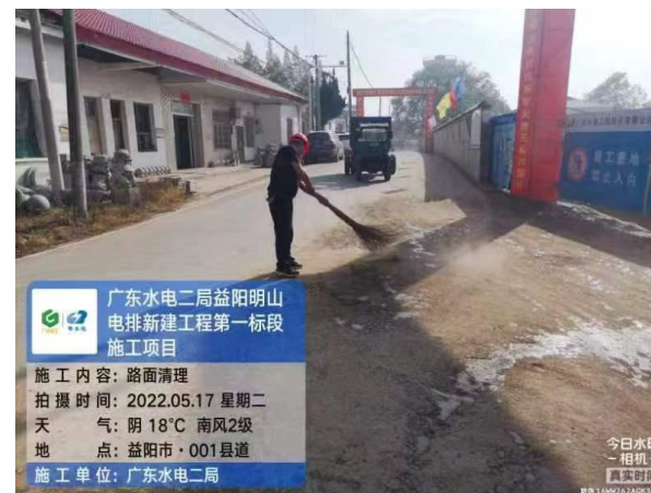
施工围挡和道路清扫
