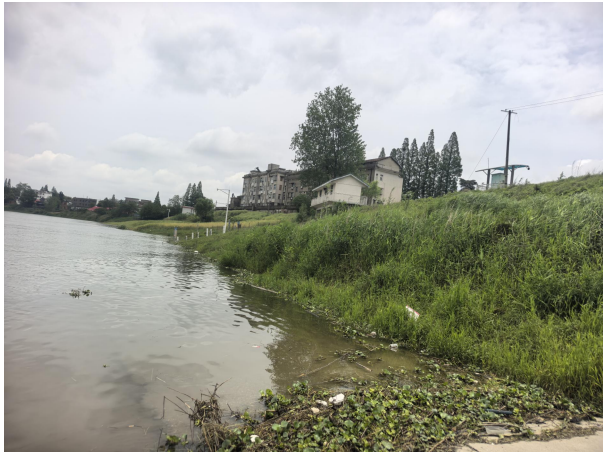
藕池东支河引排水口
