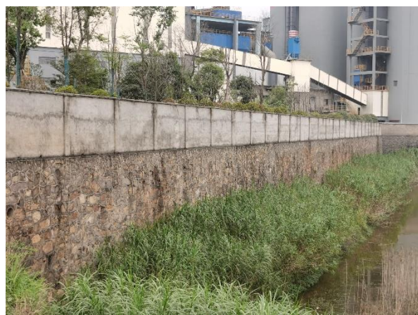
中水沉淀池外侧浆砌石挡土墙
