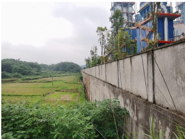
进厂大门左侧浆砌石挡墙
