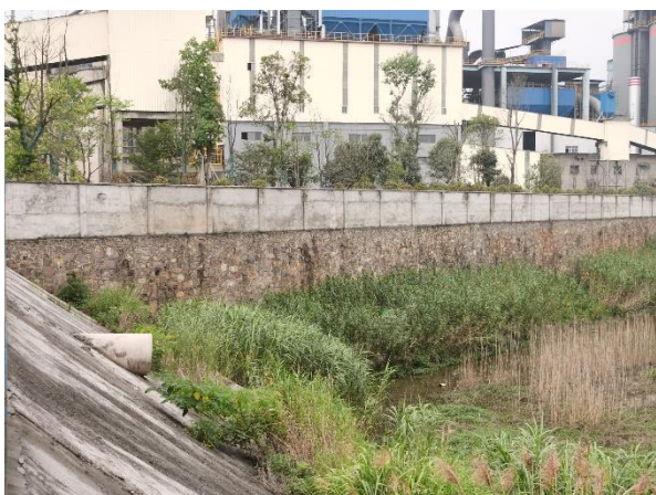
中水沉淀池外侧浆砌石、砼挡土墙及排水涵管
