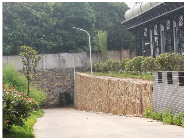
原料均化堆场处浆砌石挡土墙
