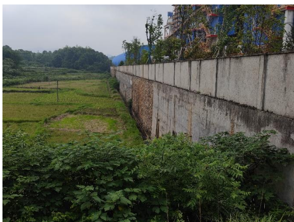
进厂大门左侧挡墙及排水
