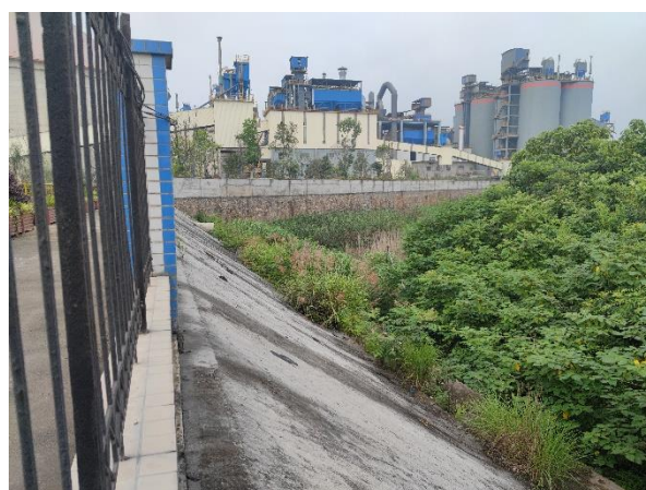
中水沉淀池外侧围墙及挡墙防护
