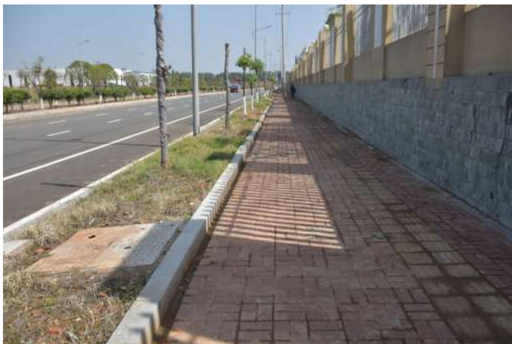
管线后期恢复为人行道
