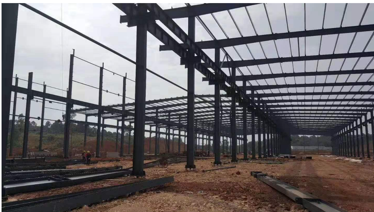
厂房建设过程（门式钢架结构）
