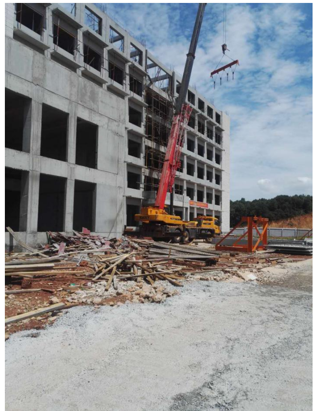
办公楼建设（装配整体式框架结构）
