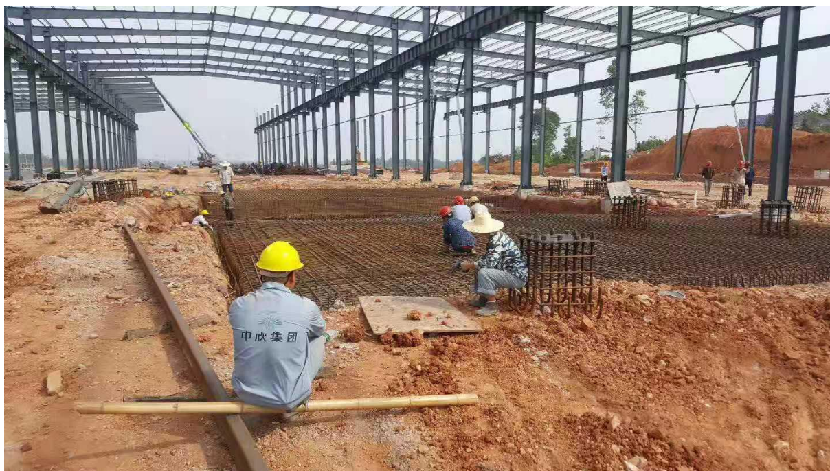
厂房建设过程（门式钢架结构）
