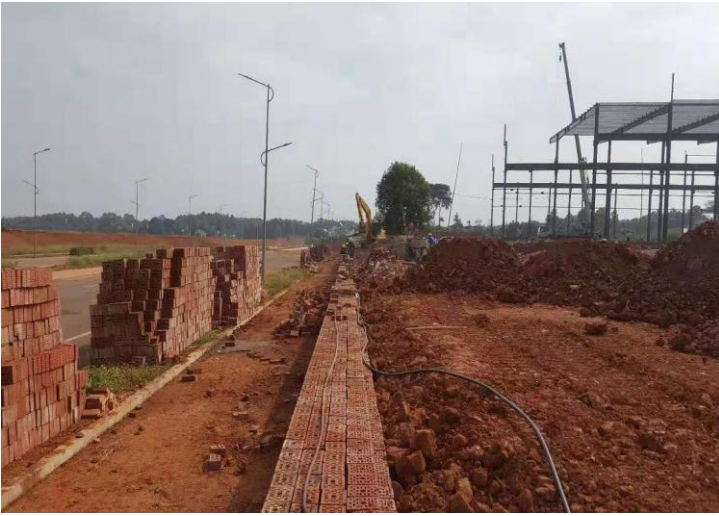
场地平整及围墙砌筑
