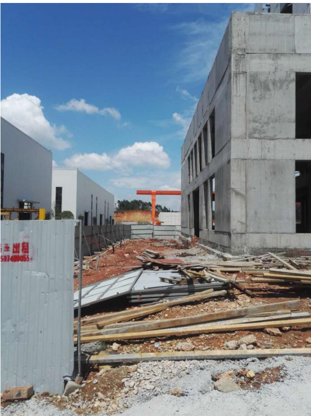
办公楼建设及临时围挡工程
