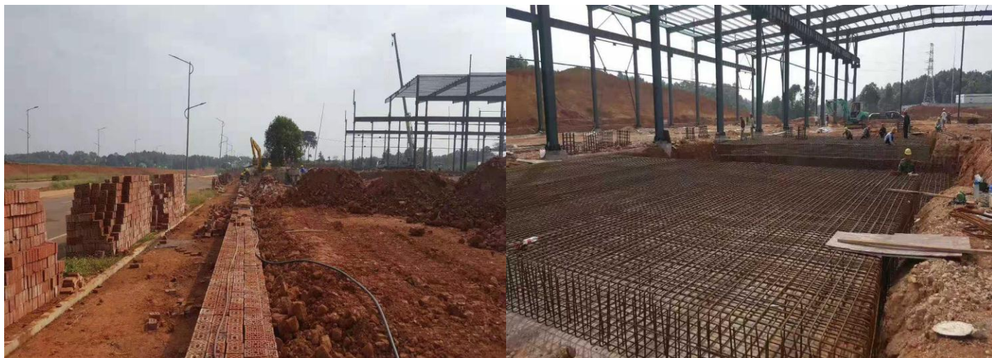
场地平整及围墙砌筑
