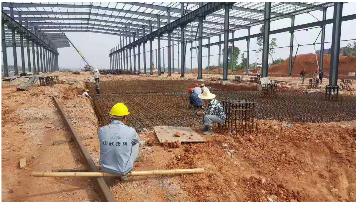
厂房建设过程（门式钢架结构）
