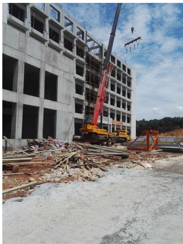
办公楼建设（装配整体式框架结构）
