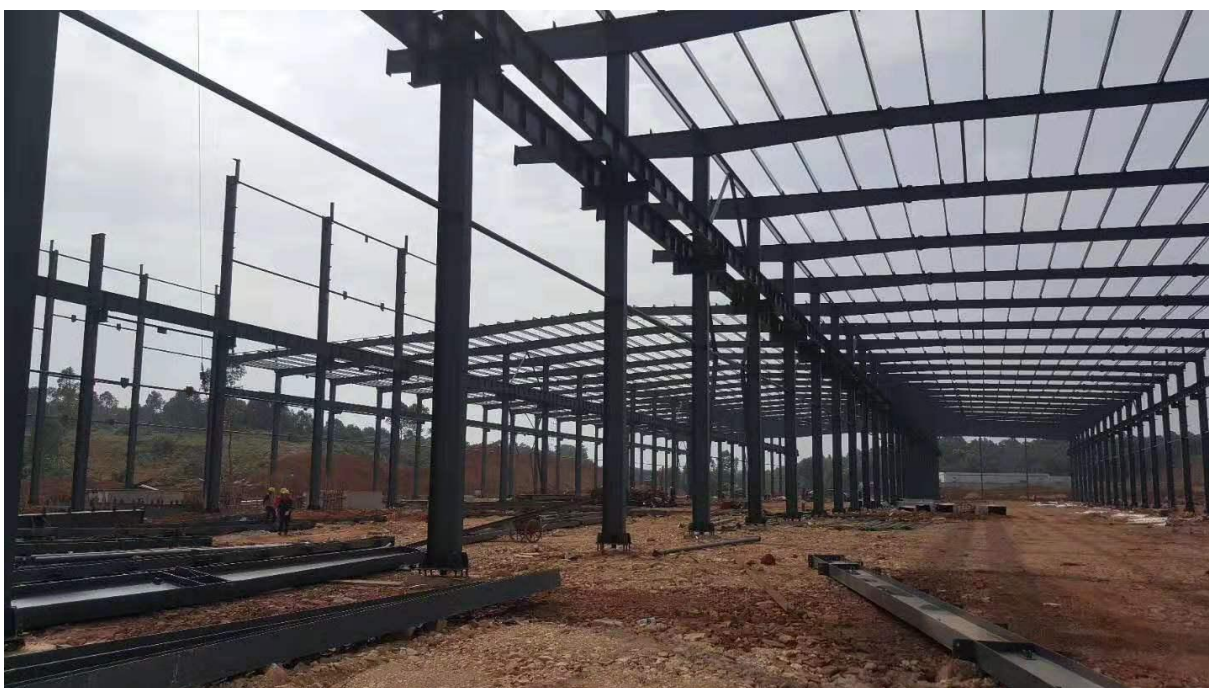
厂房建设过程（门式钢架结构）
