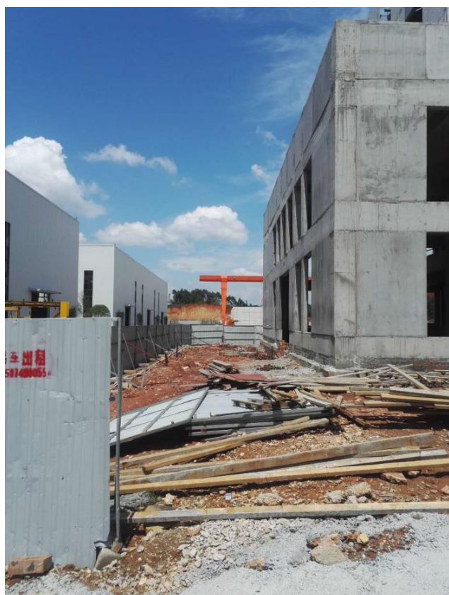
办公楼建设及临时围挡工程
