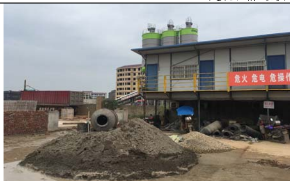
东侧施工临建区
