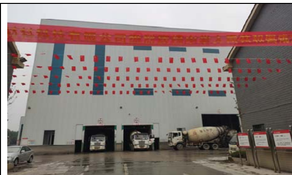
封闭搅拌主楼
