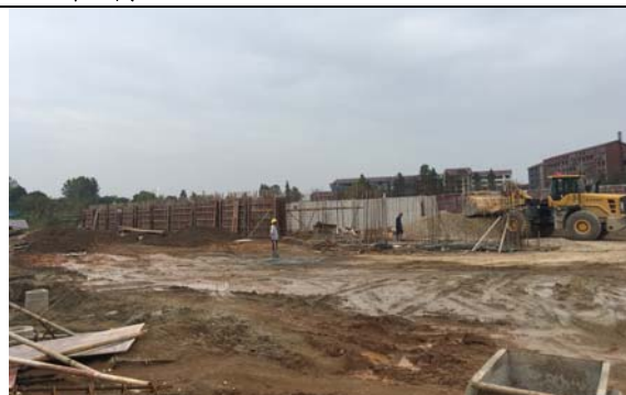
西侧搅拌车停车位现状
