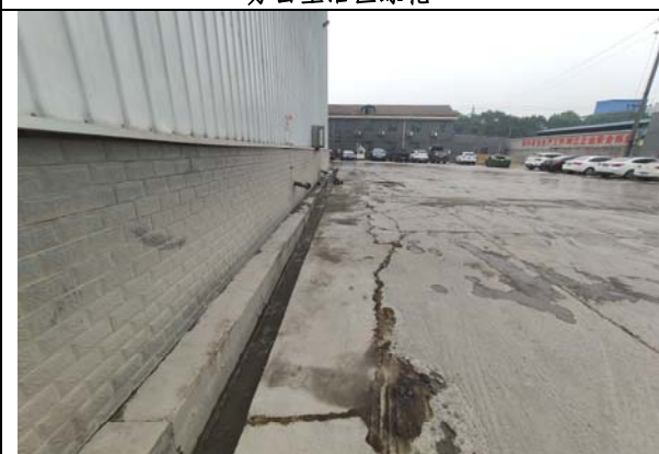
生产区砖砌排水沟
