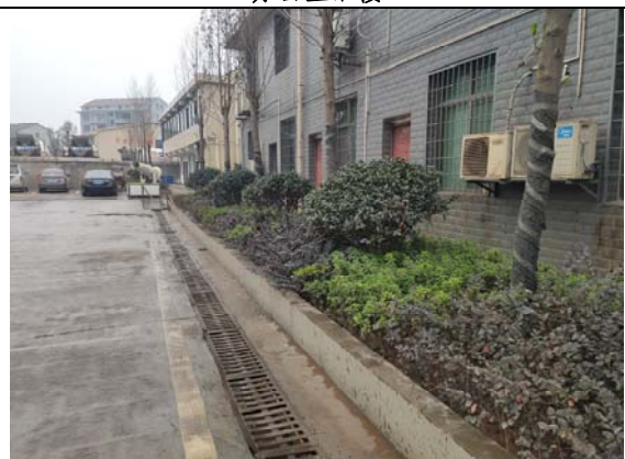
办公生活区排水沟
