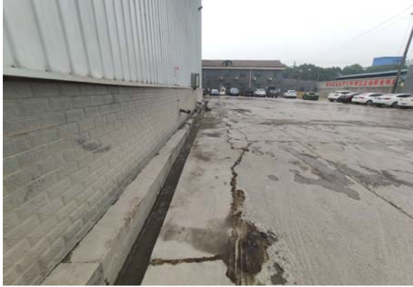
生产区砖砌排水沟
