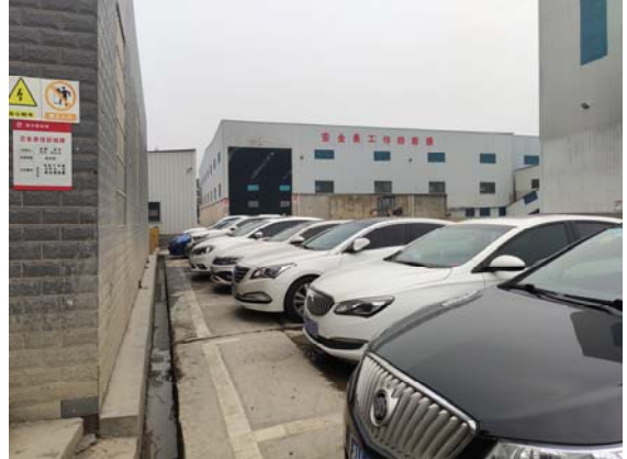
办公生活区砖砌排水沟
