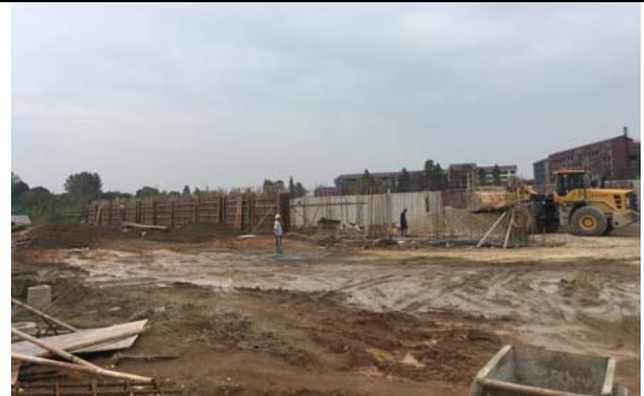
西侧搅拌机停车位现状
