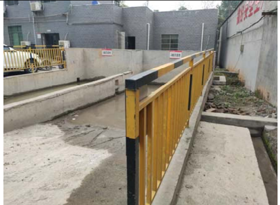
东南侧排水出口三级沉沙池
