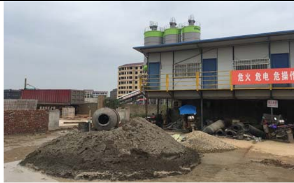
东侧施工临建区
