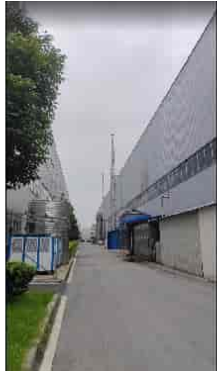
高纯车间外设施 (暂时保留)
