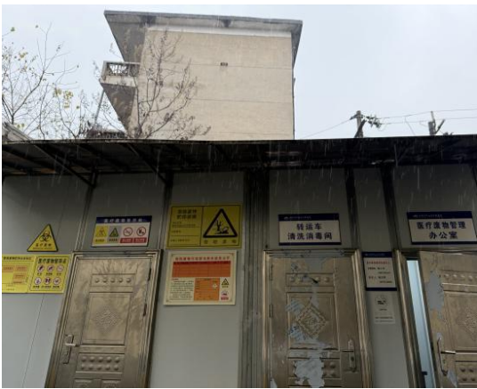
医疗废物暂存间
