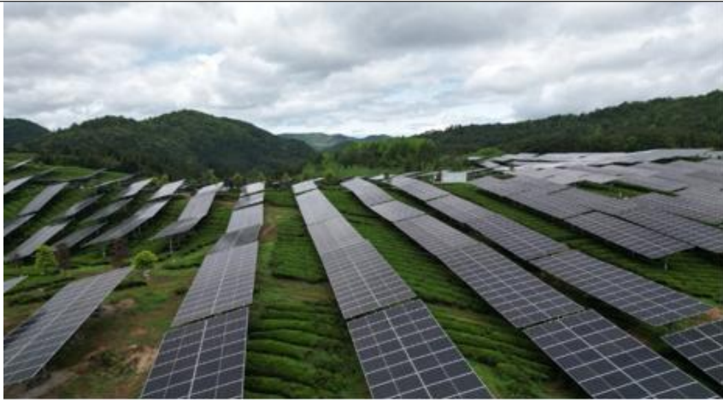
团云村已建成板区现状照片
