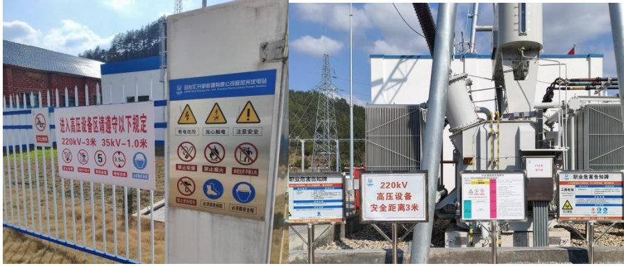
图 5-1 升压站相关警示标识
