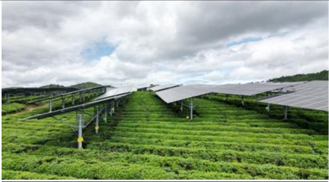
团云村已建成板区现状照片
