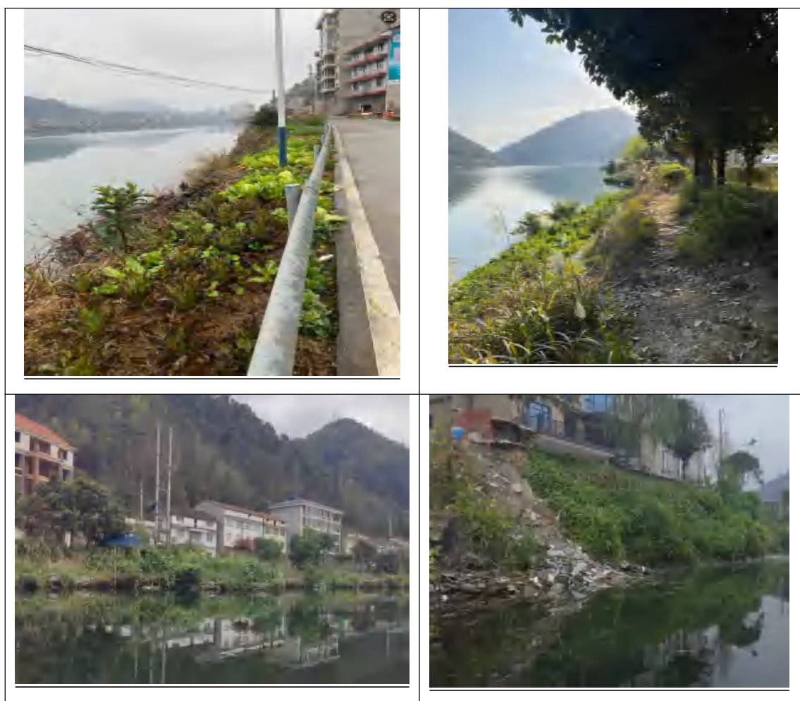
图 3.3-1 左右岸堤防现状图
