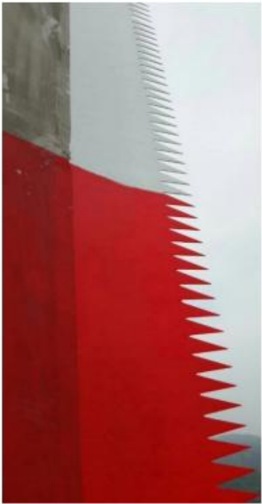
锯齿条安装完成示意图
