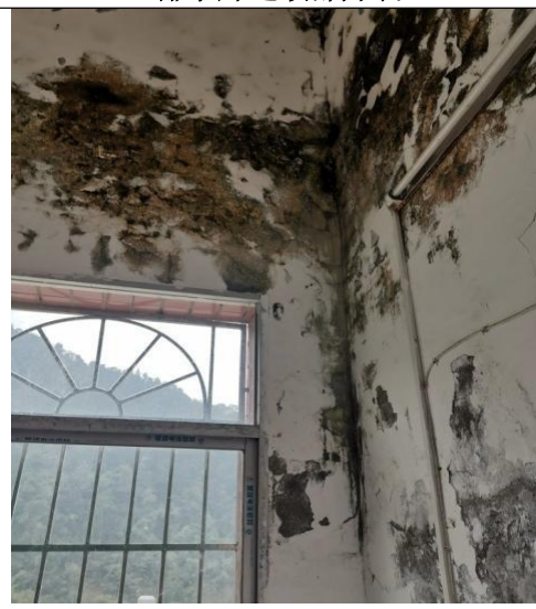
启闭机房墙身漏水、剥蚀开裂
