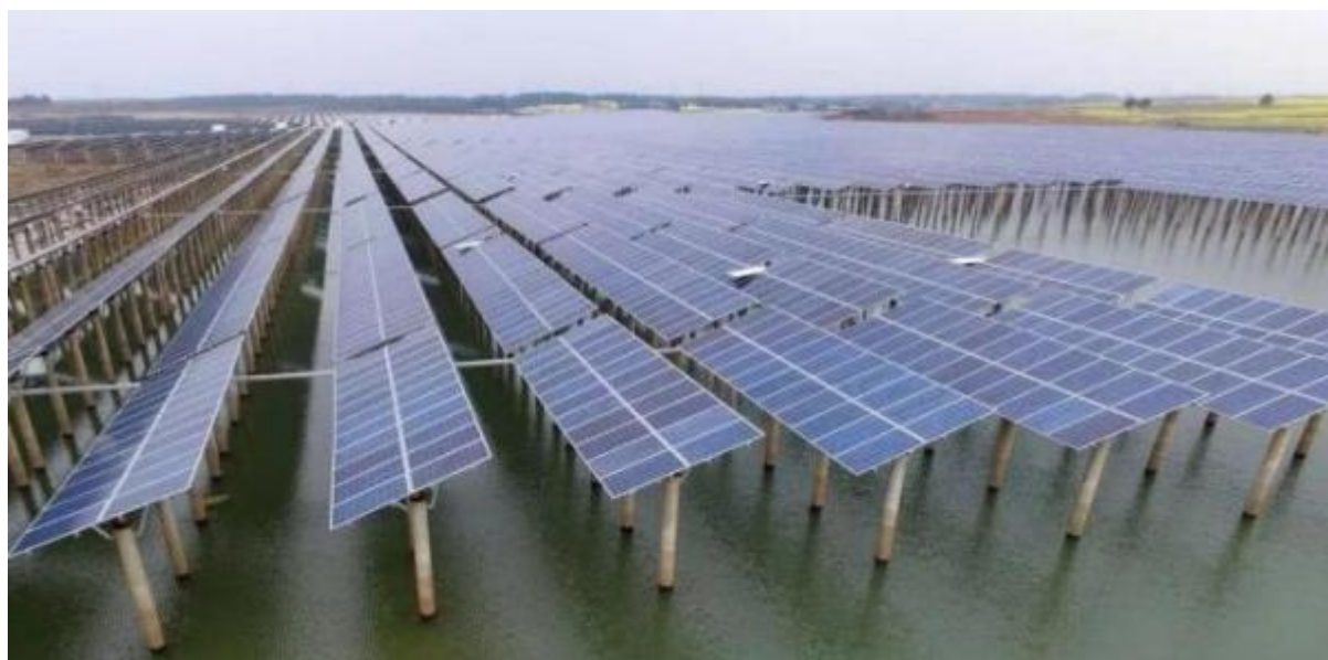
图 2-1 渔光互补固定支架安装电池阵列
