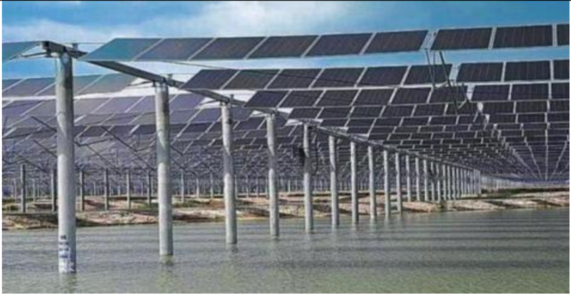
图 2-2 渔光互补柔性支架安装电池阵列
