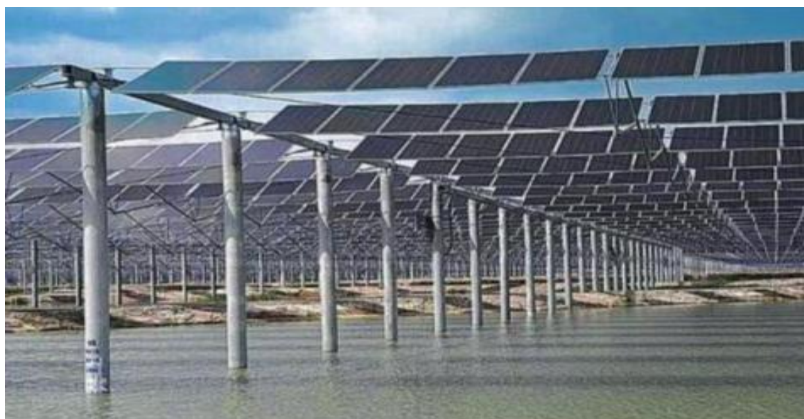
图 2-1 渔光互补固定支架安装电池阵列
