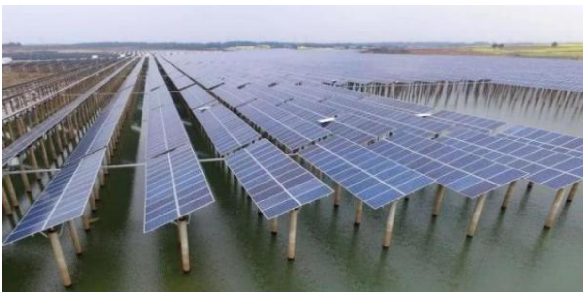
图 2-1 渔光互补固定支架安装电池阵列
