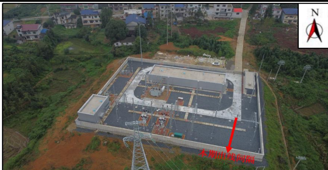
小河村 110kV 变电站 110kV 间隔扩建侧环境现状
