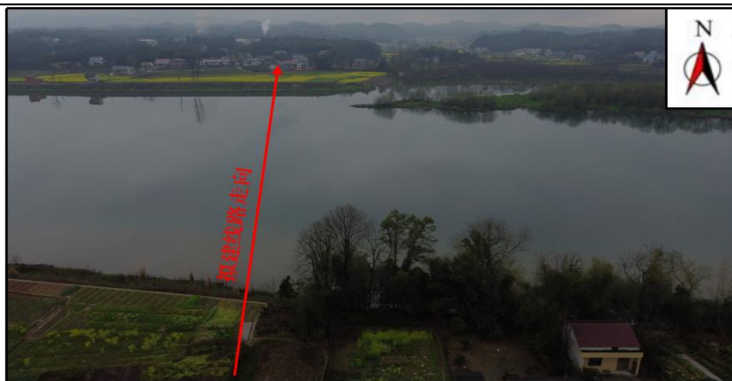
拟建线路穿越羞女湖湿地公园保育区环境现状
