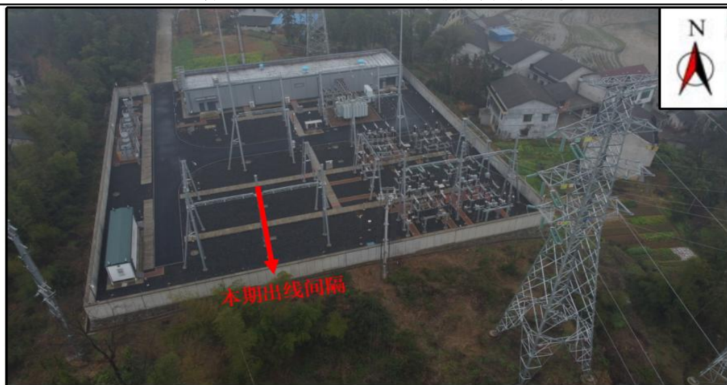
三堂街（大屋山）110kV 变电站间隔扩建侧环境现状
