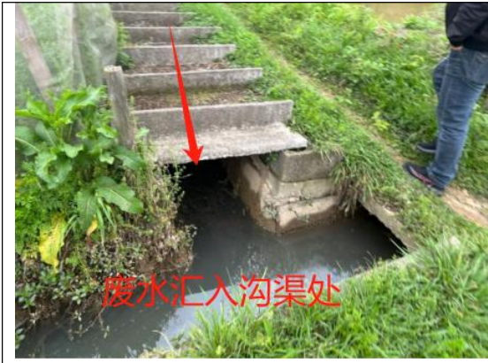
医院废水汇入渠道处
