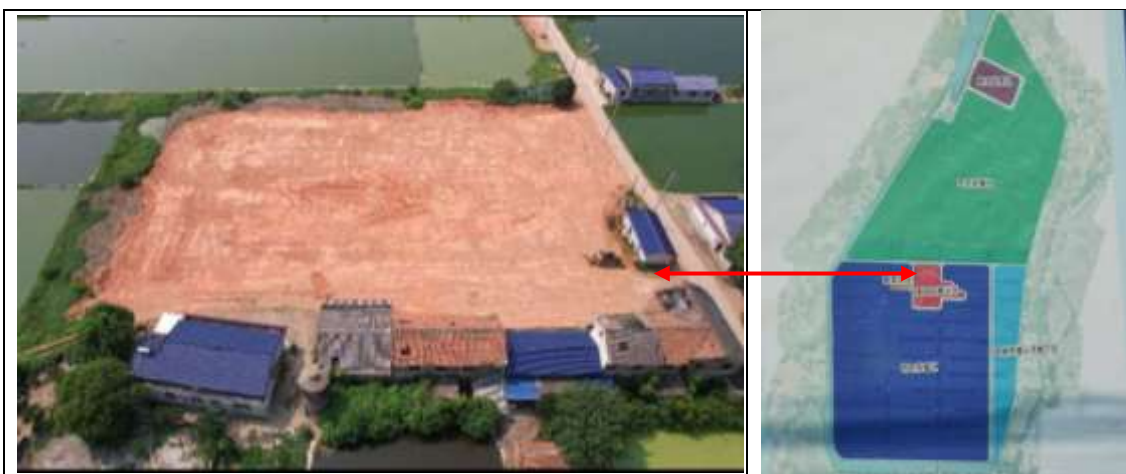
临建设施区域航拍现场照片
