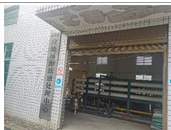
渗滤液处理中心
