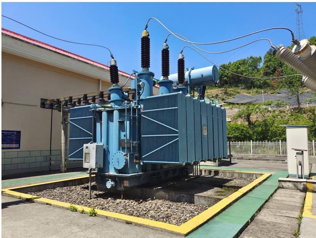
图 4-6 本项目主变压器下方围堰及卵石层
