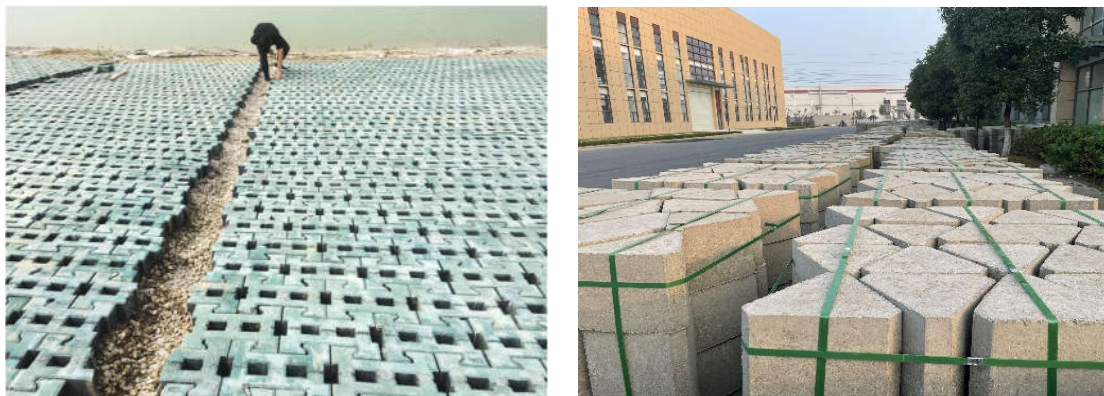
图 2.3-9 生态固化土制作生态护坡砖、防汛抛石示意图
