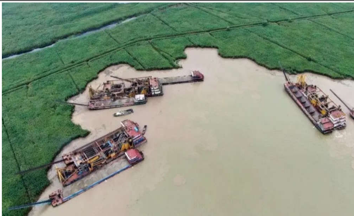
图 2.4-1 钻探船深层疏浚示意图
