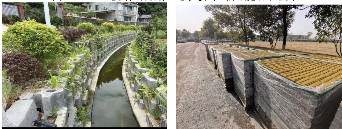
图 2.3-9 生态固化土制作生态护坡砖、防汛抛石示意图
