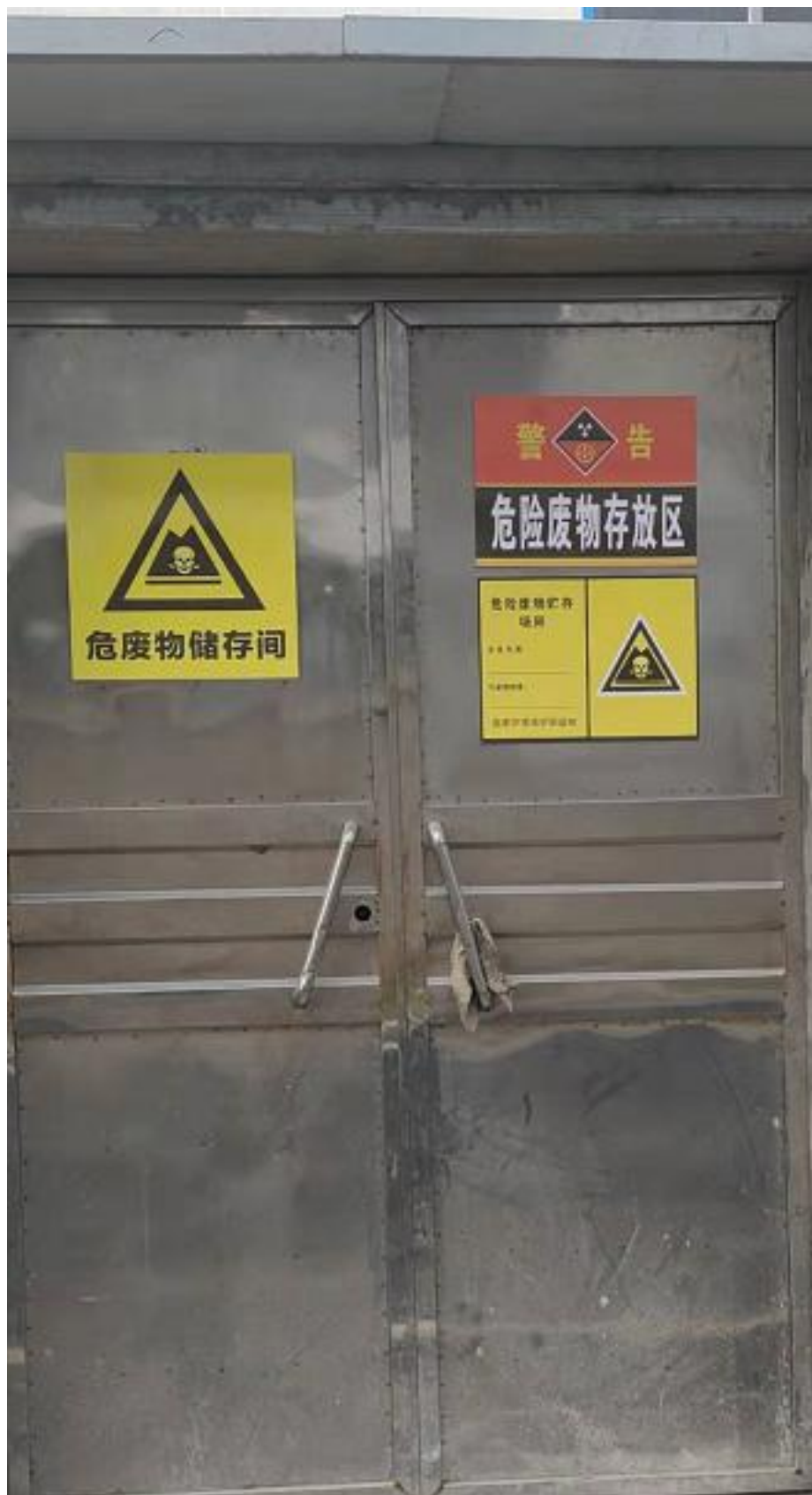
附图 3 危废暂存间
