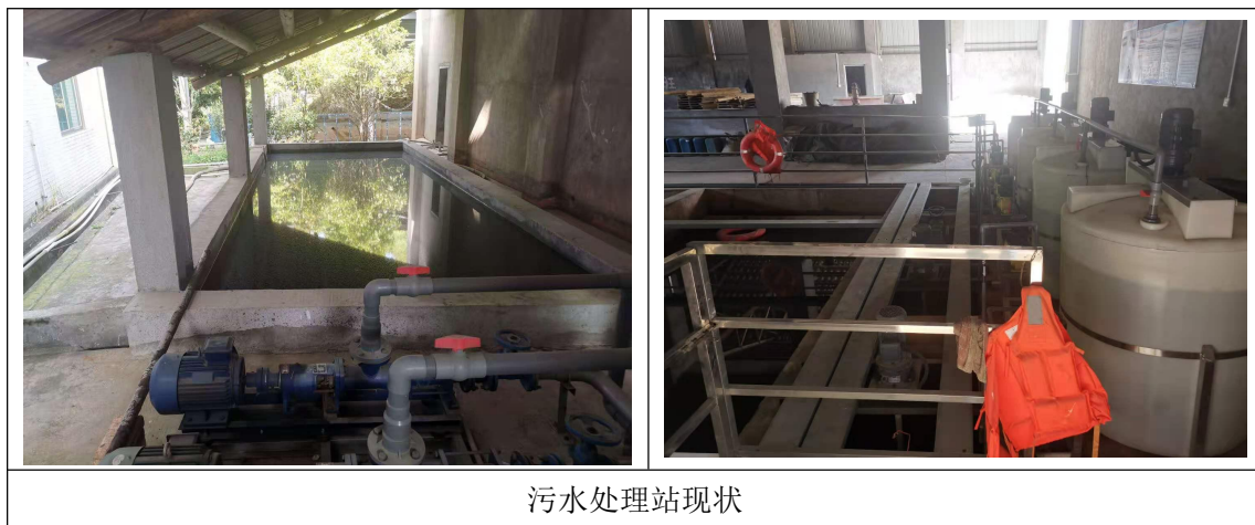
图 3.3-1 污水处理站现状图
