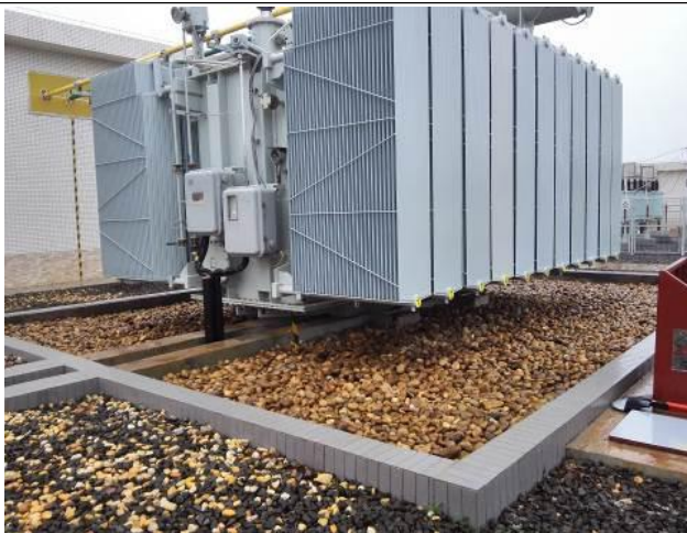
主变压器底座废油渗透收集层
