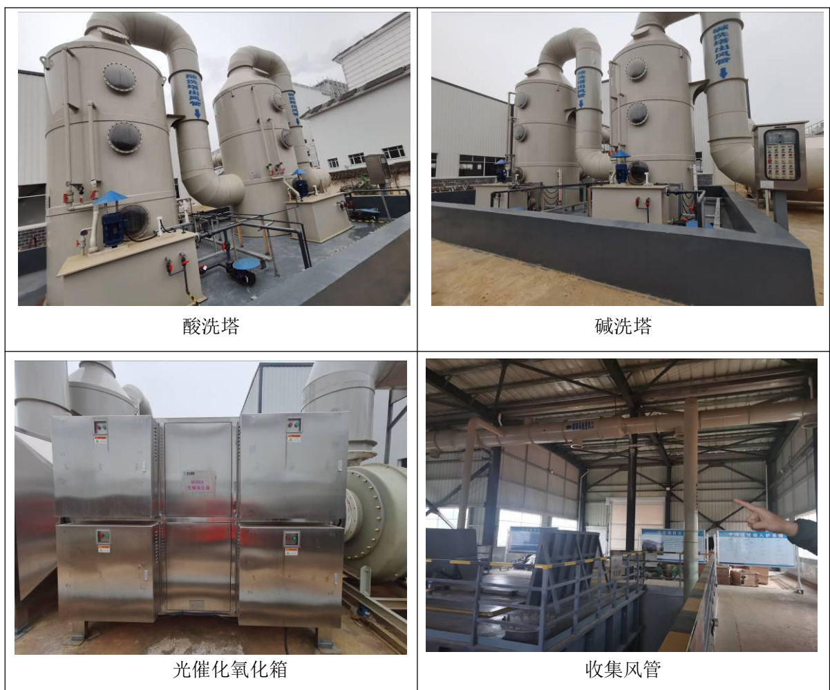
图 3.5-5 臭气收集及导回系统现场图片
