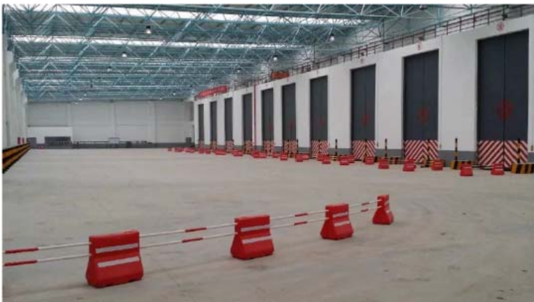
图 3.5-3 垃圾卸料大厅现场图
