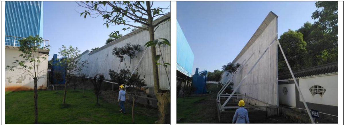
图 6.5-2 类比工程冷却塔西侧隔声屏图片
