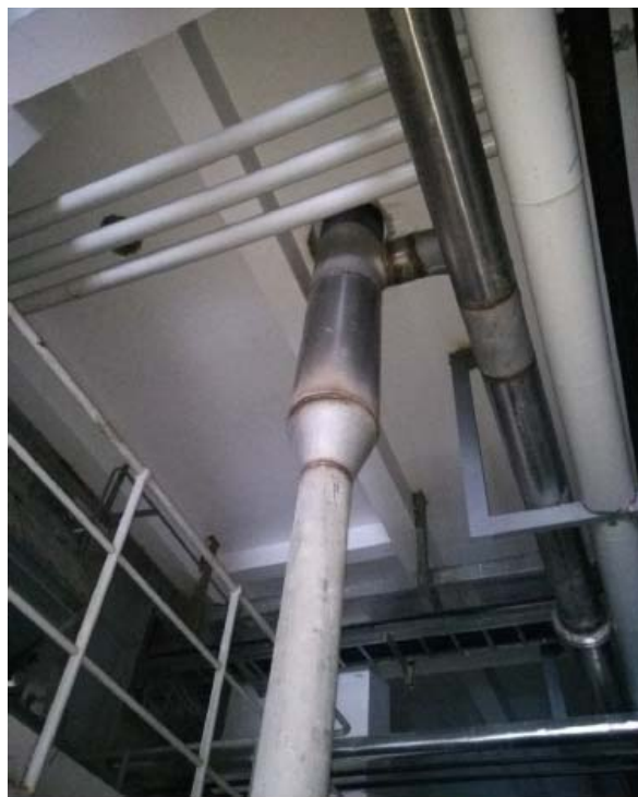
渗滤液收集管道（收集斗下）
