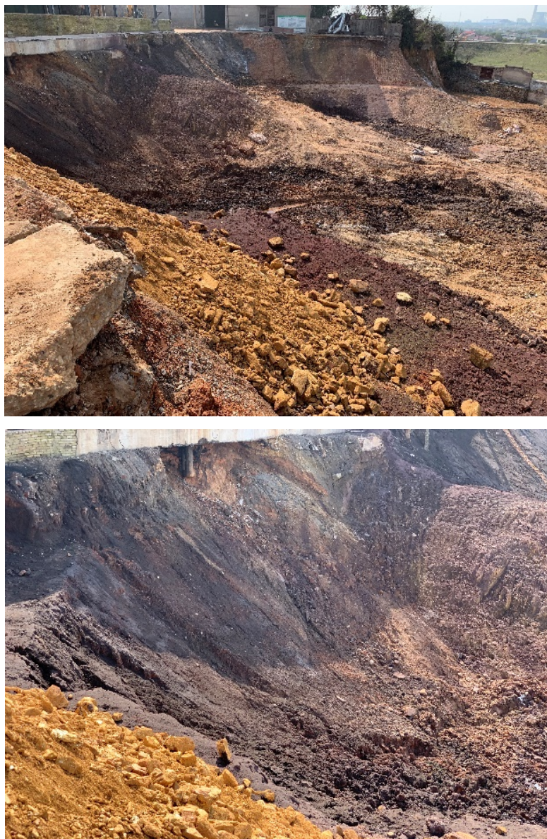
图 4.5-25 边坡土壤修复喷撒药剂后照片
