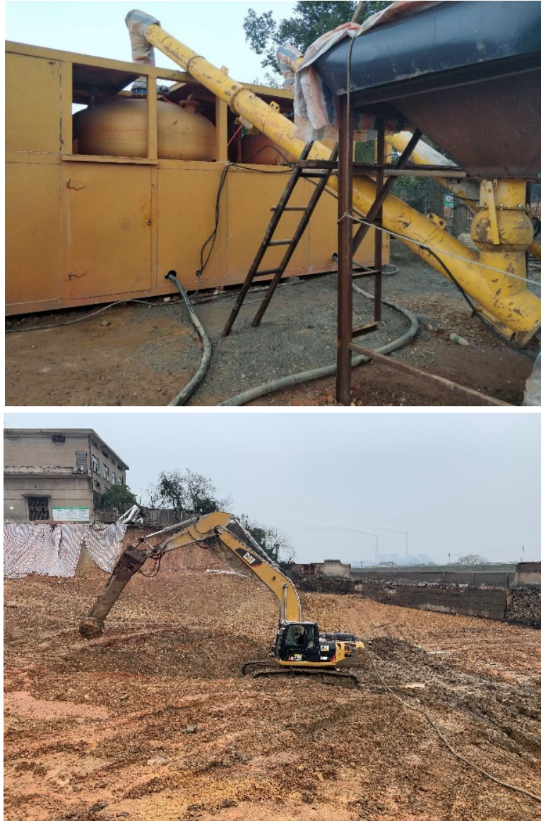
图 4.5-24 土壤原位修复机械和药剂搅拌设备照片
