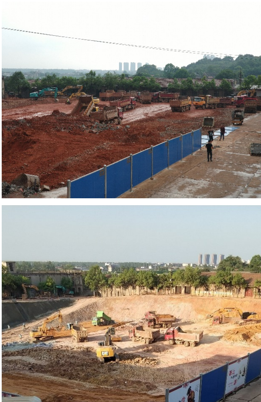
图 3.4-13 基坑开挖土方外运照片
