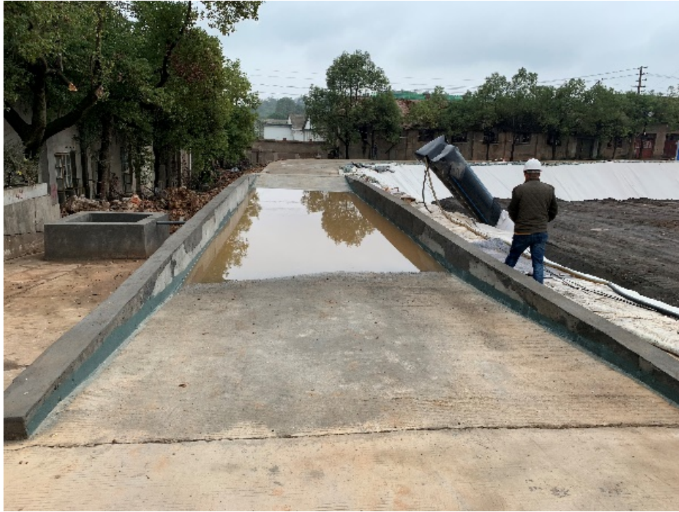
图 3.4-6 车辆和出场道路扬尘控制措施照片
