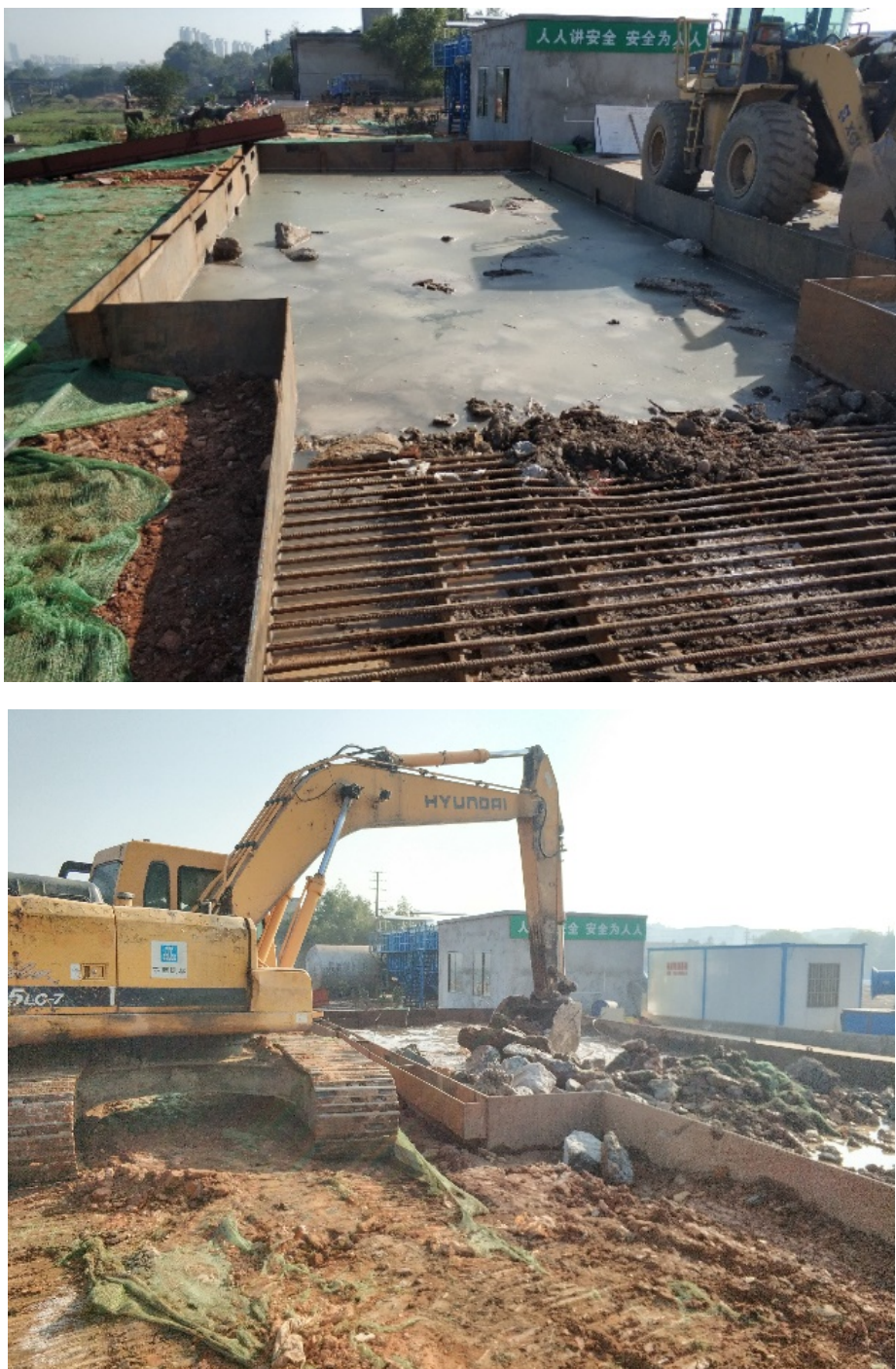
图 3.4-11 建筑垃圾浸泡照片
