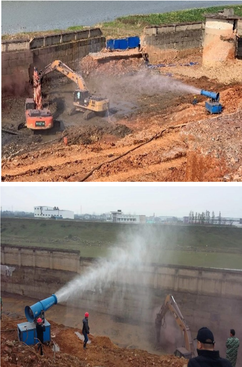
图 3.4-9 原位土壤修复扬尘控制措施照片
