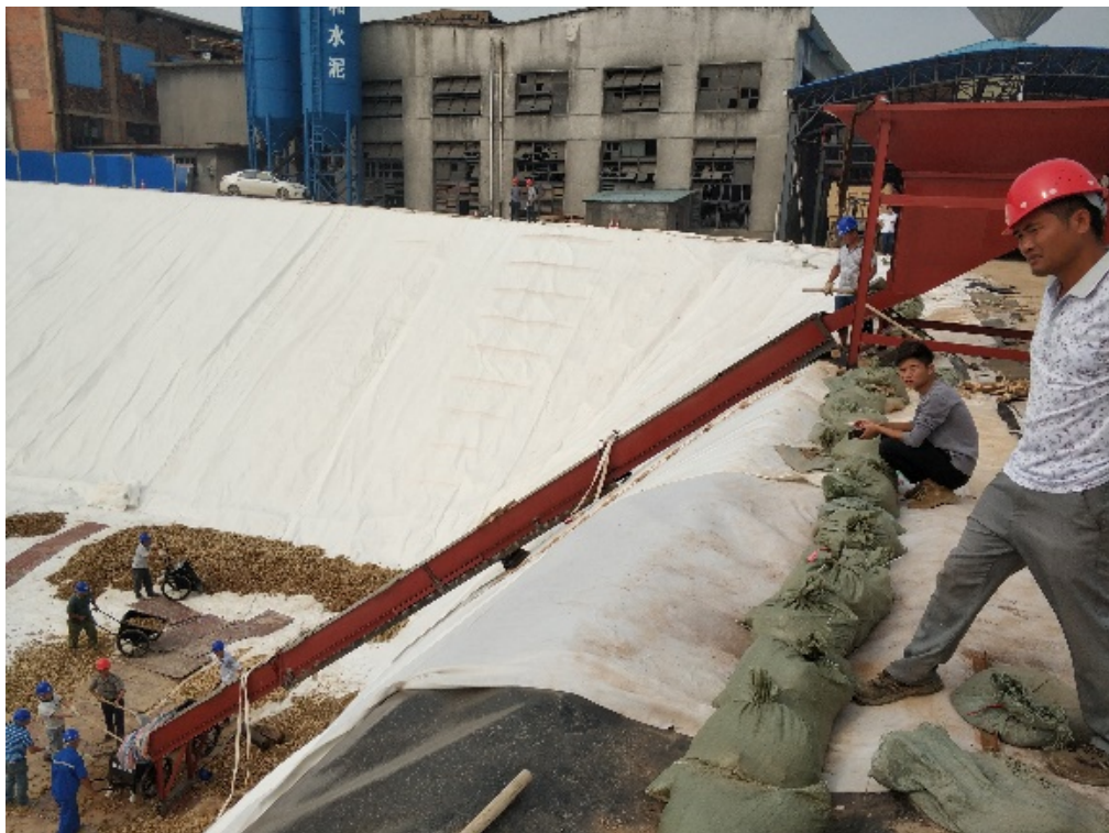
图 4.5-7 溜槽运输卵石至填埋场库底照片
