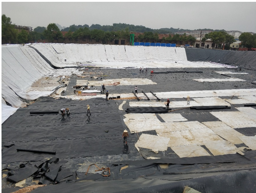
图 4.5-6 填埋场防渗膜铺设全景
