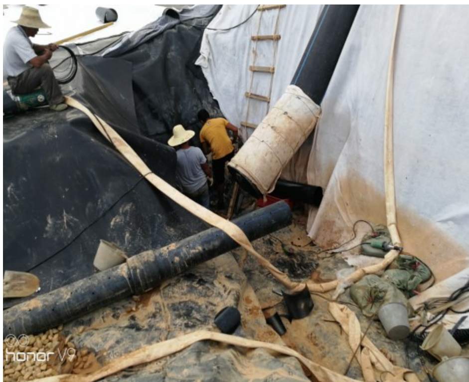
图 3.4-2 导流管的安装
