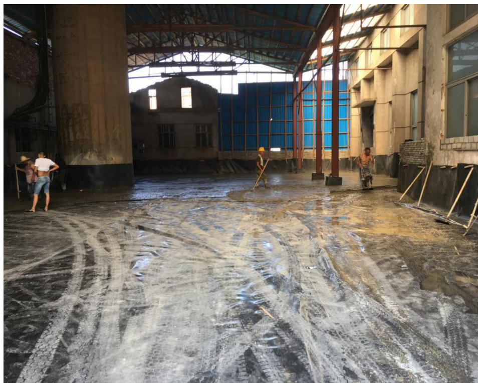
图 3.4-4 治理车间防渗土工膜的铺设
