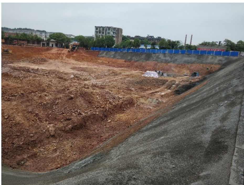
图 4.5-3 填埋场基坑边坡支护情况
