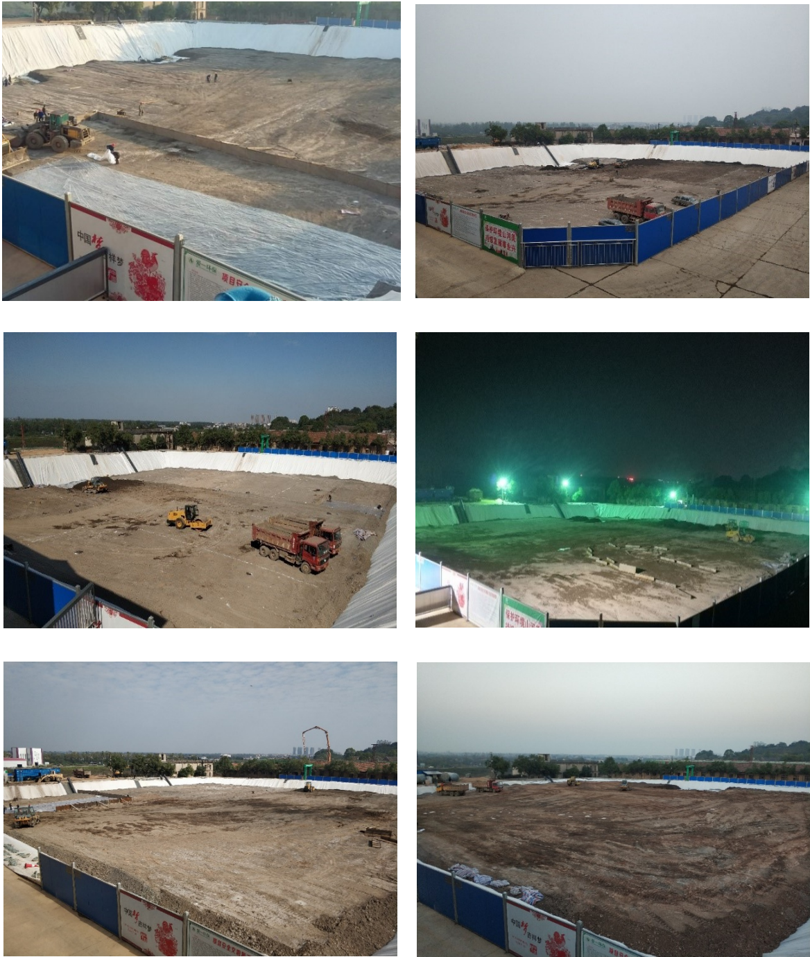
图 4.5-12 废渣分层养护填埋照片
