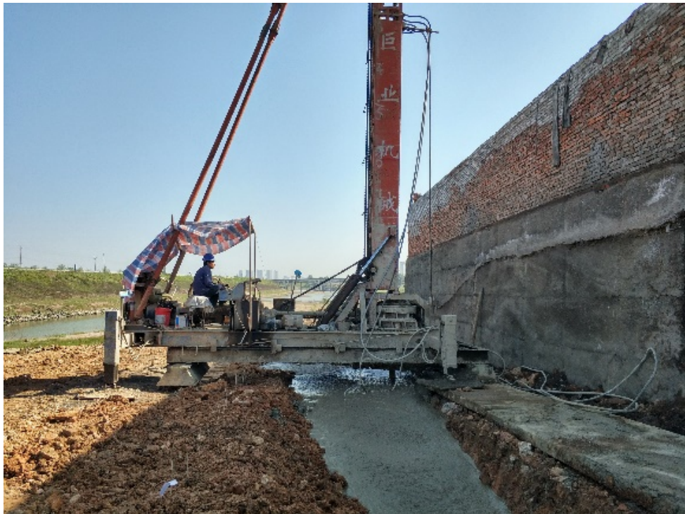
图 4.5-1 止水帷幕施工
