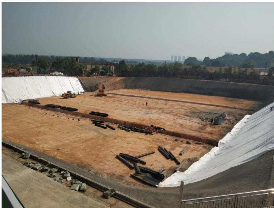
图 4.5-4 基坑库底平整
