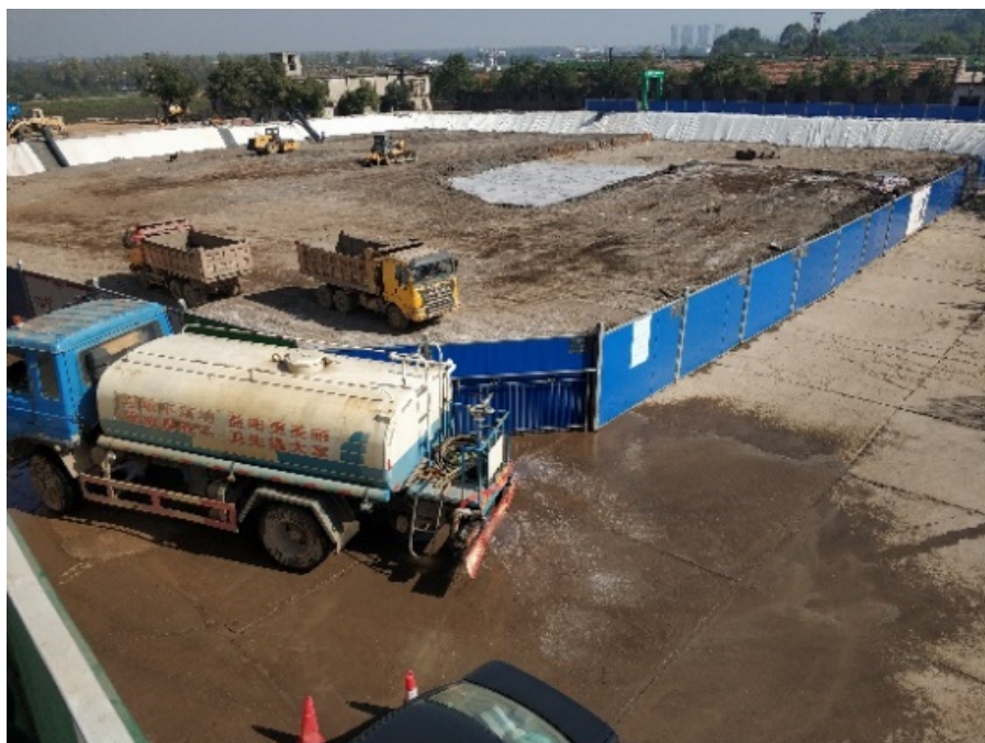
图 3.4-7 施工场地扬尘控制措施照片
