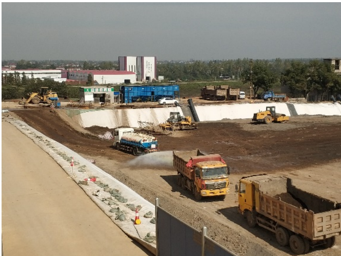
图 3.4-10 固化预处理后废渣养护照片
