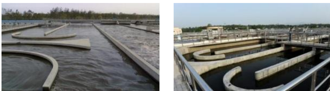
图 5-5 改良型氧化沟工艺现场图
