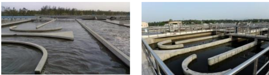
图 5-5 改良型氧化沟工艺现场图
