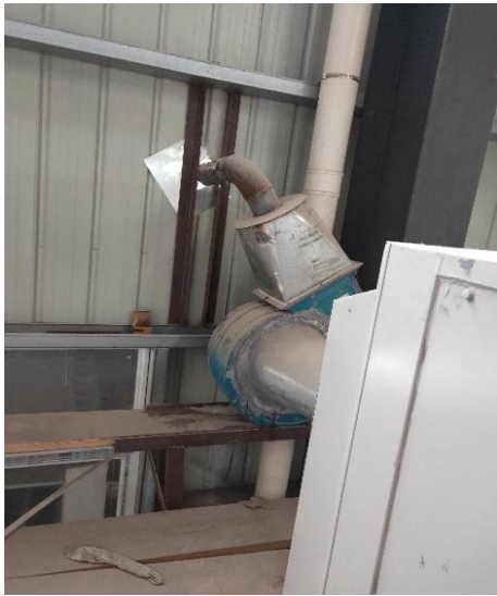
烤箱废气排气处理装置
