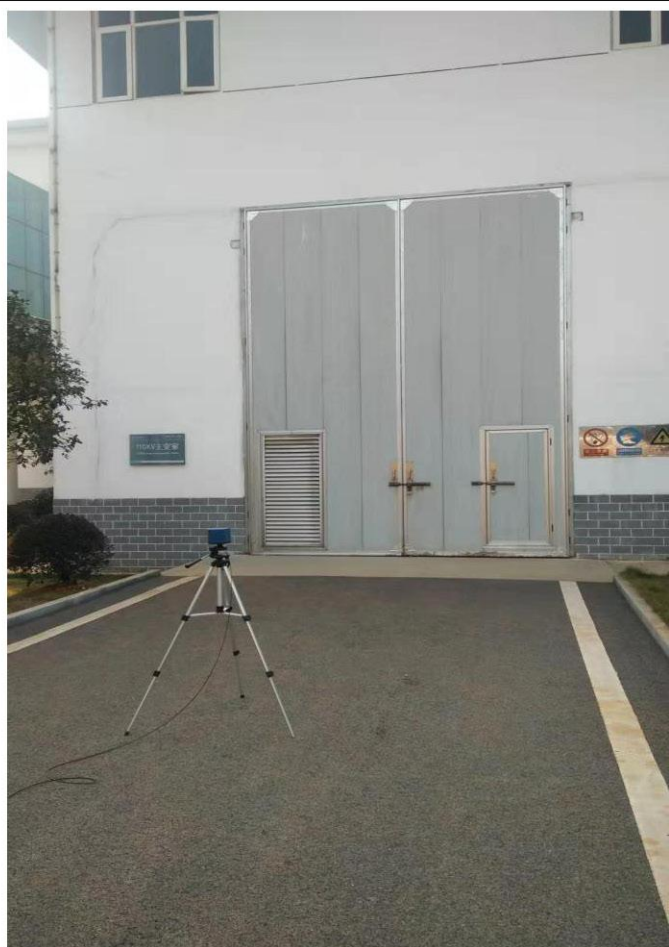
升压站站址北面
