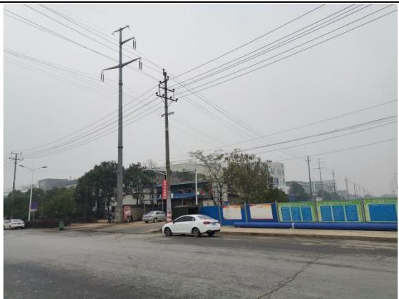
本工程已建四回塔以及待拆除线路照片
