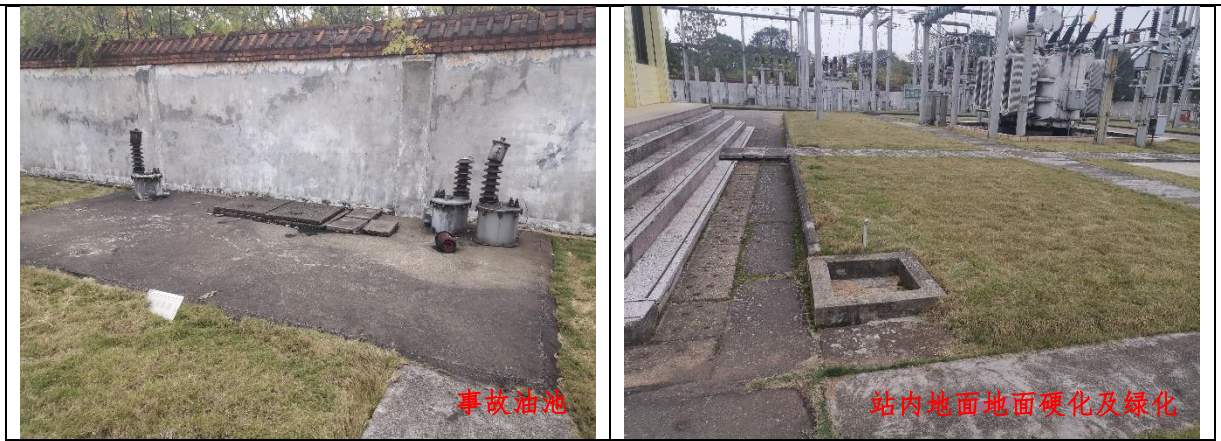
图 1 湖南益阳赫山区长坡岭 110kV 变电站 2 号主变改造工程自然环境状况
