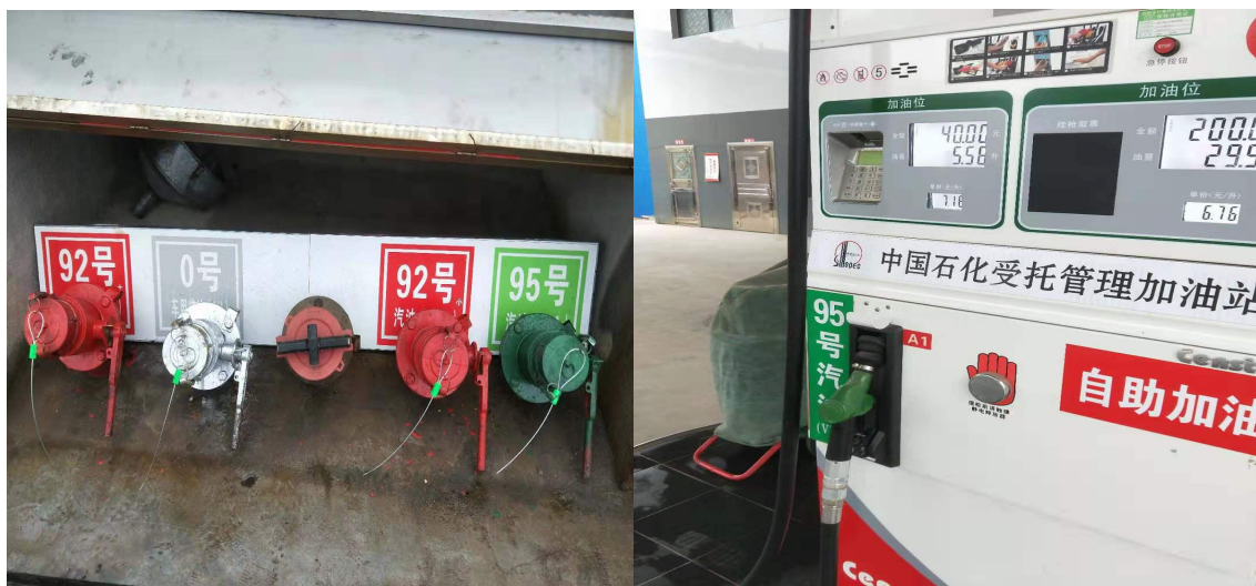
图 4.1-1 油气回收装置现场照片
