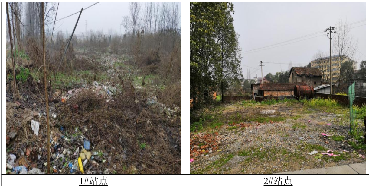
图 1-1 阳罗洲镇污水处理站厂址现状照片
