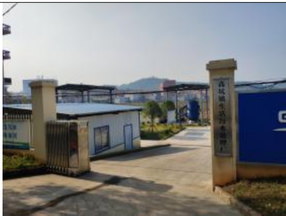
高坑镇污水处理站
