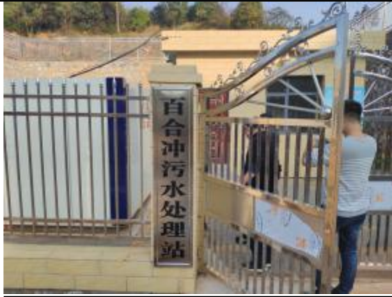
百合冲污水处理站
