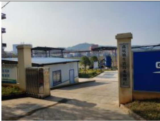
高坑镇污水处理站
