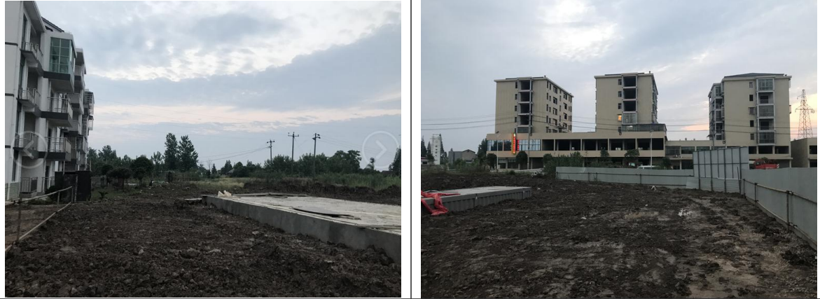
2#污水处理站厂址现状照片
