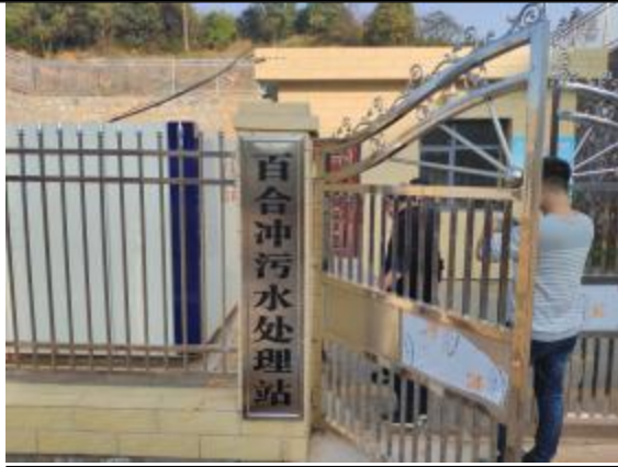
百合冲污水处理站
