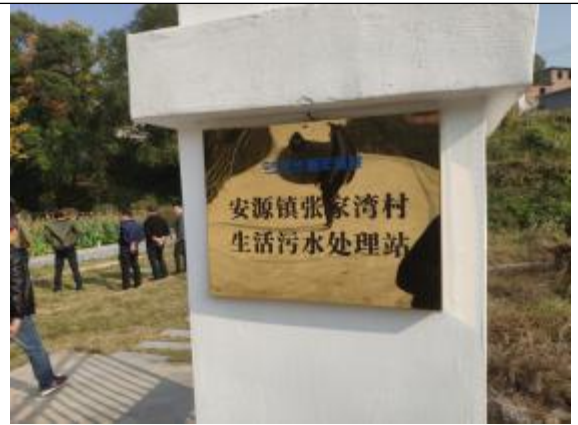
安源镇张家湾村生活污水处理站
