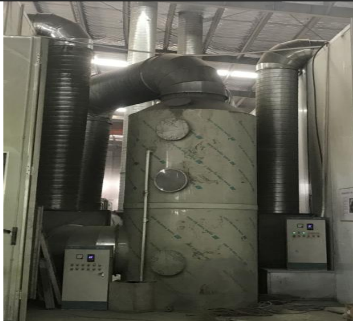
喷淋预处理废水
