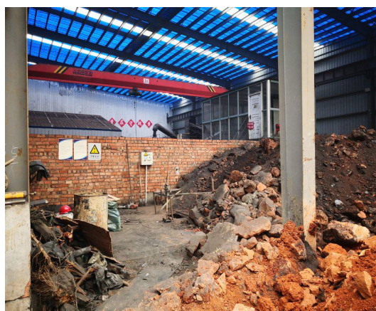
一般固废暂存场
