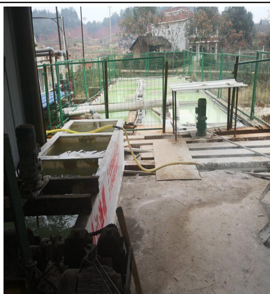
循环水沉淀池
