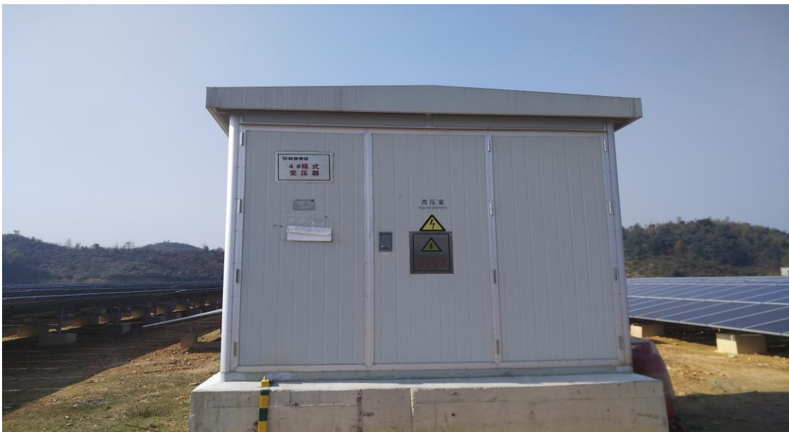
图 6-2 箱式变压器
