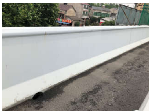
桥面雨水收集口
