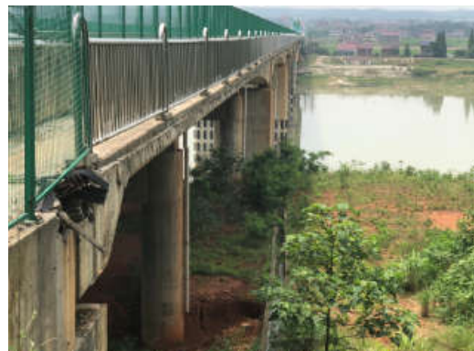
桥梁汇水管道
