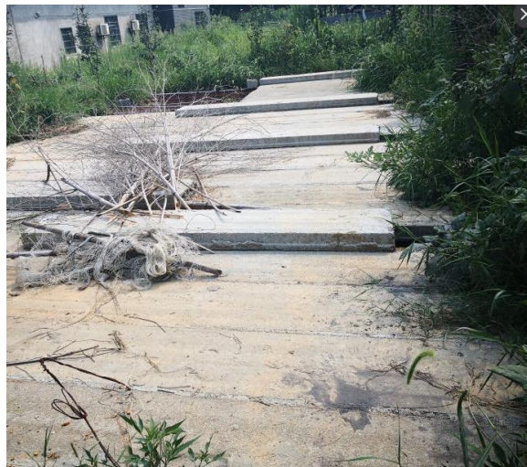
废水处理系统的“三级沉淀+ 混凝沉淀池+ 气浮池”
