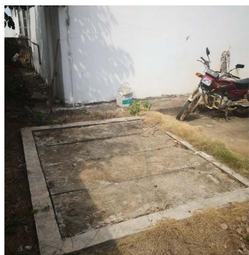
污水处理设施
