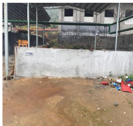
工业废物暂存池
