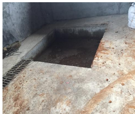
污泥暂存间渗滤液收集池
