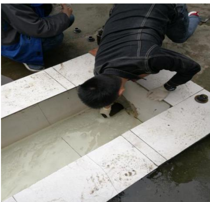
废水处理站出口
