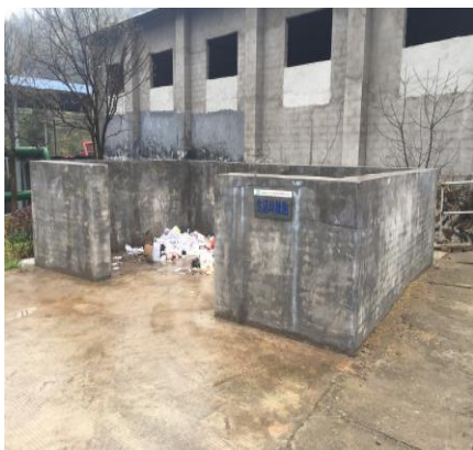
生活垃圾暂存点
