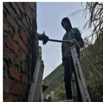
锅炉废气出口
