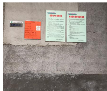
危险废物暂存间
