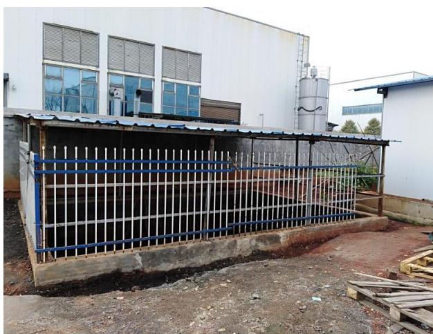
应急池及防雨顶棚
